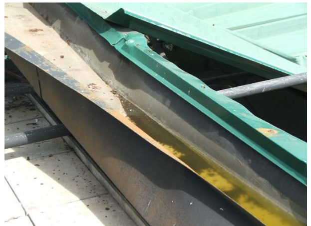
Foto 9 – Detalhe do estado da calha de captação das águas pluviais, com ausência de corrosão.
