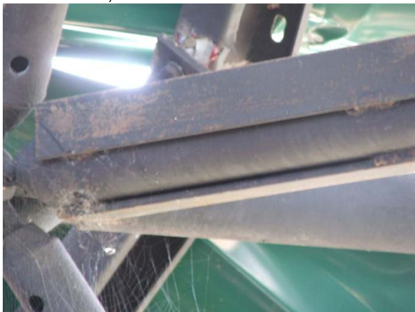
Foto 14 – Detalhe da estrutura com barras de reforços estruturais em forma de perfis do tipo cantoneiras, soldados as barras tubulares.
