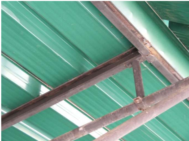
Foto 6 – Detalhe da fixação da cobertura, com ausência de corrosão e boa fixação.
