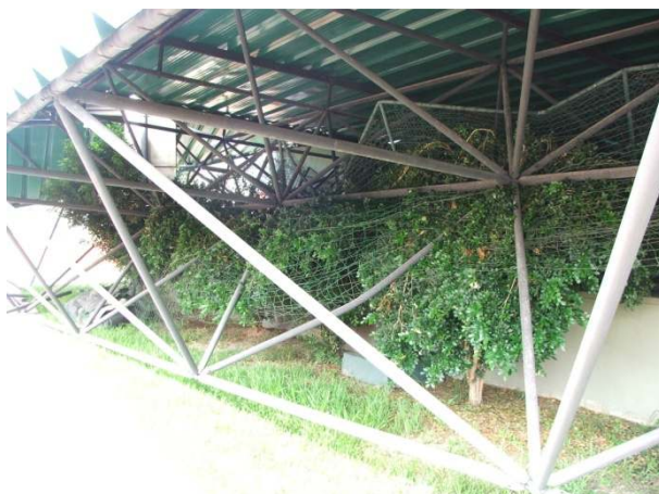
Foto 4 – Detalhe da estrutura parcialmente montada e apoiada sobre o piso, fixações em bom estado.
