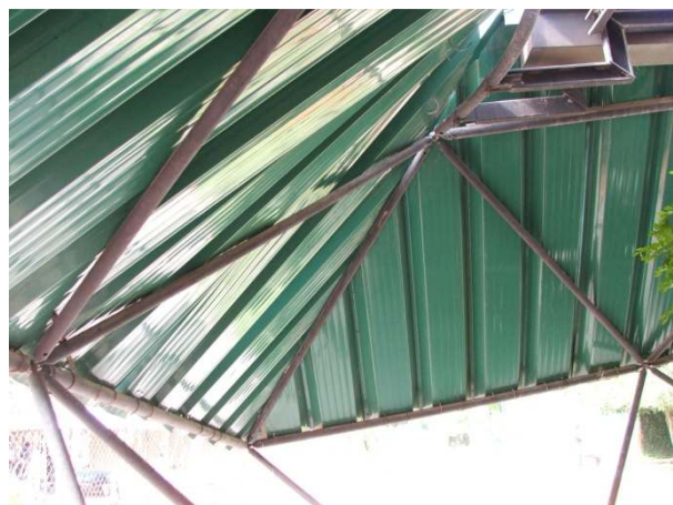
Foto 5 – Detalhe da cobertura da estrutura com ausência de corrosão e telhas bem fixadas.
