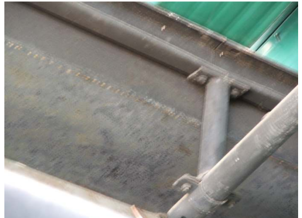
Foto 7 – Detalhe da fixação da cobertura e ausência de danos nas calhas de captação de águas pluviais.
