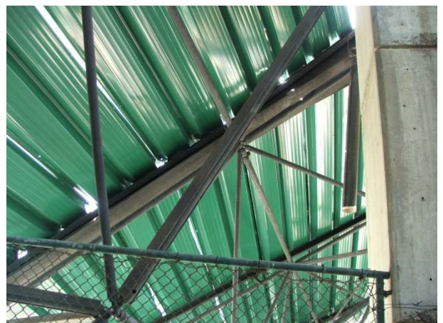
Foto 11 – Detalhe da estrutura com barras de reforços estruturais em forma de perfis do tipo cantoneiras, soldados as barras tubulares.
